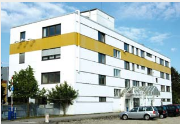
Bürogebäude in Puchheim vor Bestandsentwicklung
