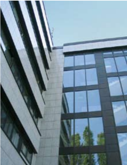
Innere Kanalstraße, Köln
